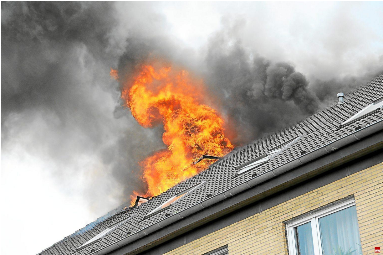
Am 9. Juni 2011 brannte der Dachstuhl eines Mehrfamilienhauses an der Ochtruper Straße. (Foto: Klaus Wiedau)
