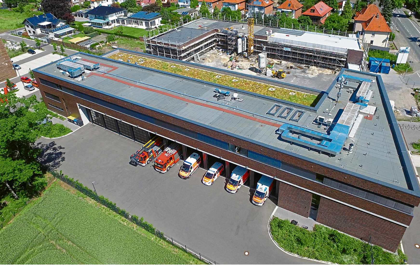
Mit der Planung der neuen Feuer- und Rettungswache an der Eper Straße wurde 2014 begonnen. Nach dem Abriss der alten Feuerwache wurde im vergangenen Herbst mit dem zweiten Bauabschnitt begonnen.
