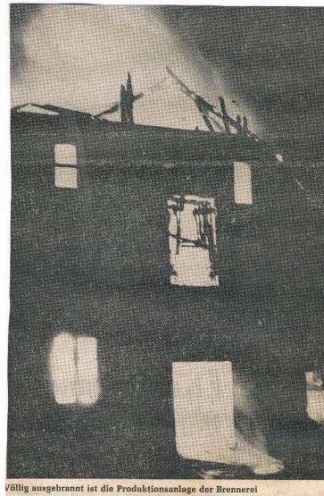
Völlig ausgebrannt ist die Produktionsanlage der Brennerei
